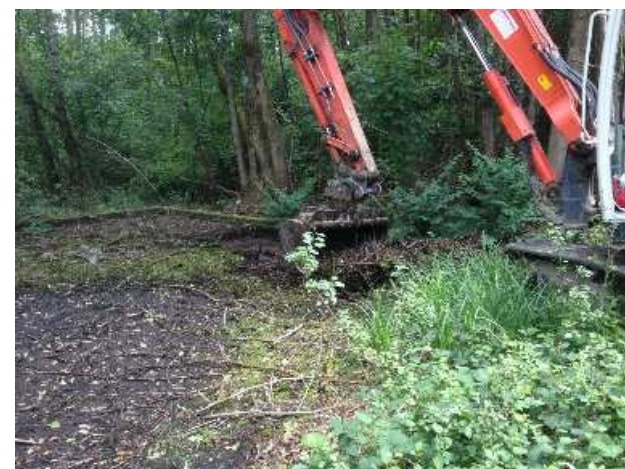
Baggerarbeiten zur Ansiedlung des Kammolches
